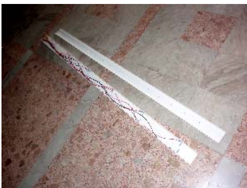
箱型水位計完成
