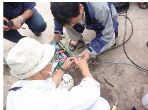
ケーブル側接続端子作り
