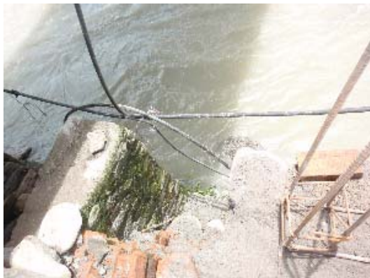
設置予定箇所
