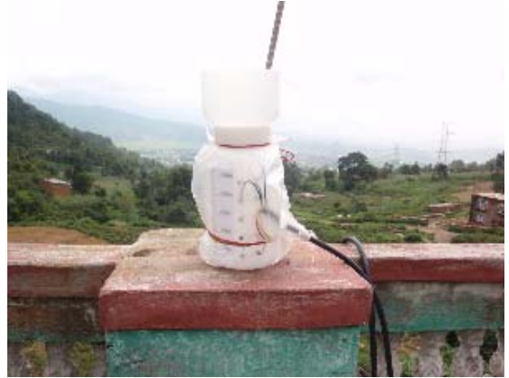
雨量計側接続完了
