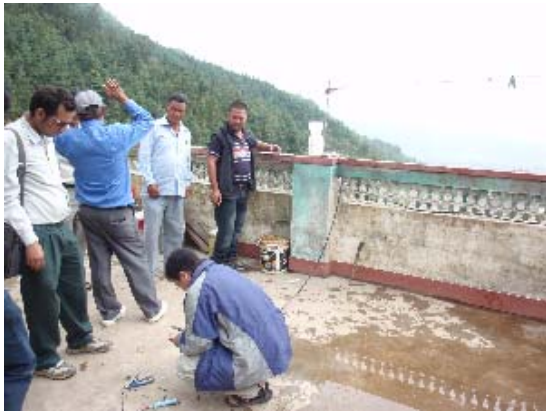
ケーブル側接続端子作り
