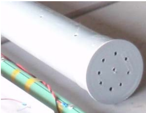
ケーシングに底蓋を取り付け、通水孔を空ける
