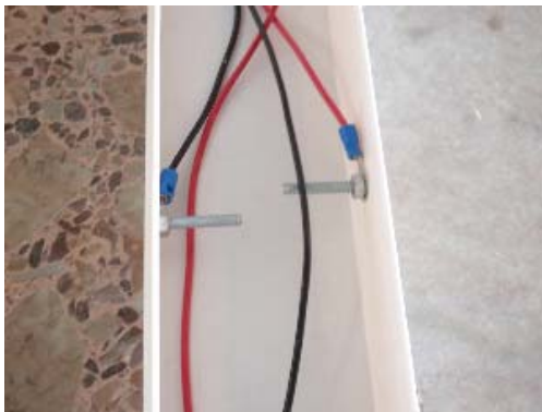
箱型内部のセンサーと配線
