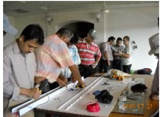
内部配線作業
