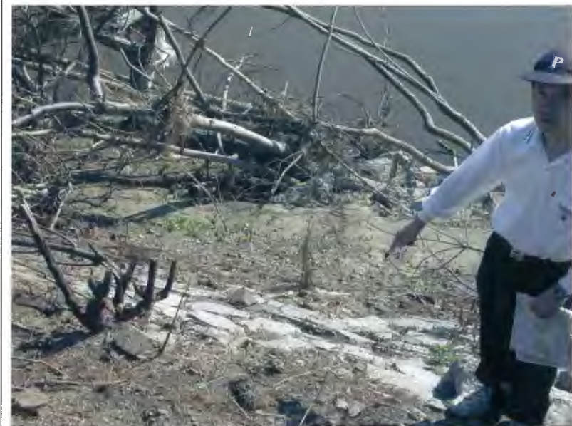
ブルタバ (モルダウ) 川左岸部護岸堤
