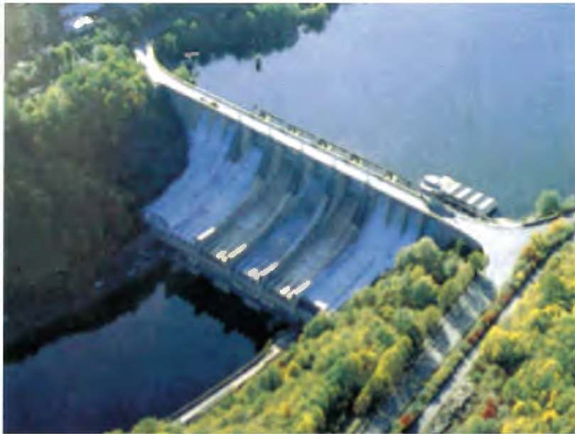
スラピーダム全景
