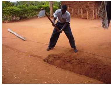
配線用溝掘削
