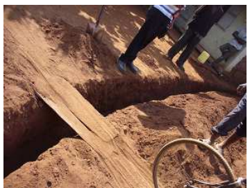
出来上がっていた掘削 JST15:11
