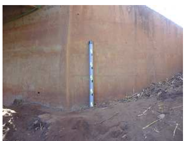
道路橋台に置いてみる
