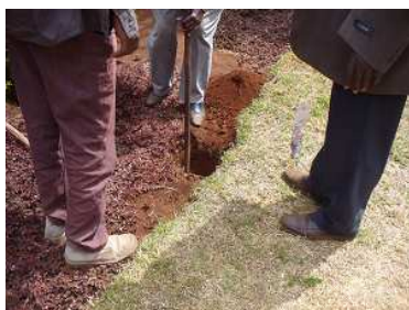
雨量計支柱穴掘り
