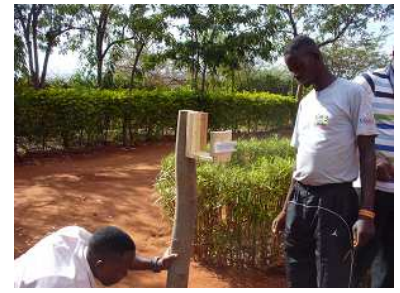
雨量計架台取付
