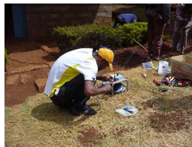
配線端部処理
