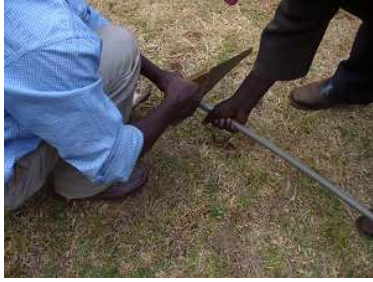
配線カバー切断
