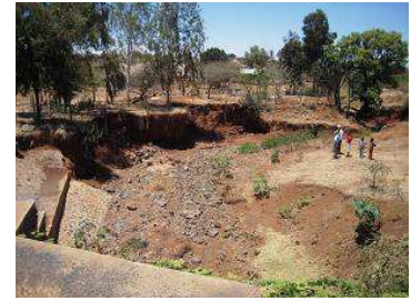
布団カゴ護岸実施予定箇所
