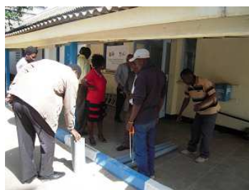
水位監視計ケーシング切断
