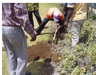
支柱用穴掘り
