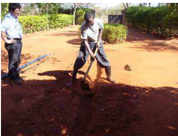
埋設線掘起し
