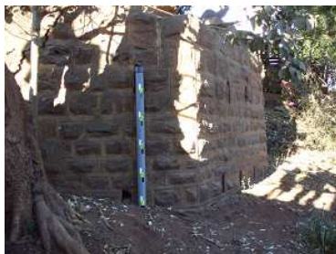
旧鉄道橋台に置いてみる
