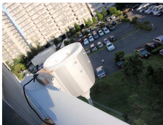
写真-2 ベランダから張出した受水部
