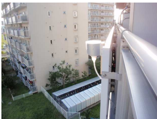
写真-1 ベランダから張出した受水部
