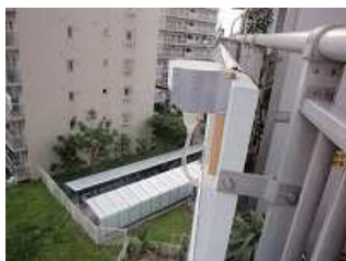
写真-1 ベランダ受水部
