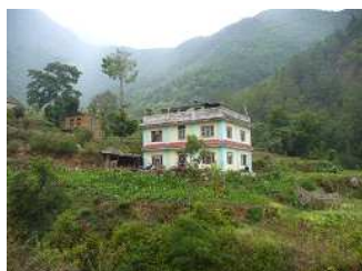
この家の屋上に雨量計を設置
