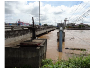
12号線の橋。 パラベットの高さに比べて、橋桁が低い。 今後、河川水位があがるとここがボトルネックに。 Yom川にDamがあれば、下げられるか？
