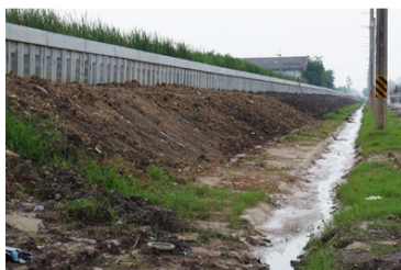
(ほぼ完成(さらに盛土をするらしい。))
