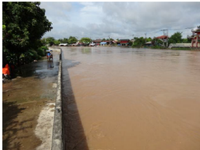
堤防の外。 流速は、場所によって1.2mくらいある感じ。
