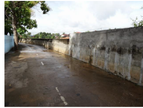
部分的？にWallが嵩上げされている。
