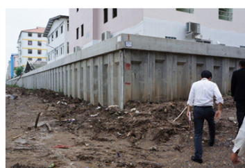
コーナー部は比較的きれいな施工。
