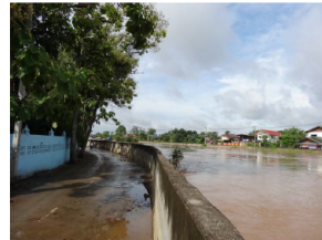
堤防の内。 微量だが、Wallからの漏水も複数みられる。
