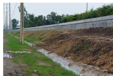
(ほぼ完成(さらに盛土をするらしい。))
