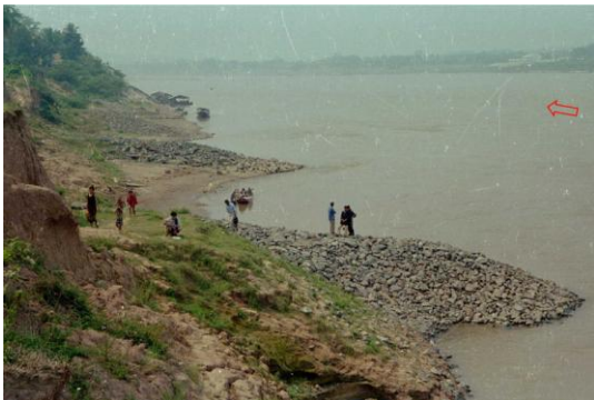
写真-6 完成した1, 2, 3, 4号基 (2000年4月)
