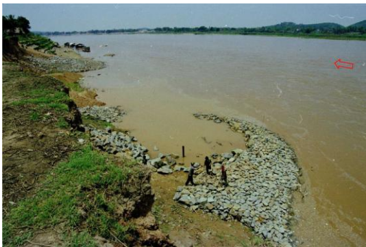
写真-5 建設中の1, 2号基 (1998年5月)
