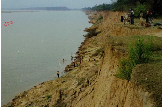
写真-1 河岸侵食の全景 (1998年2月)
