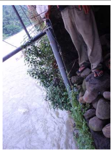
水位計取り付け状況
