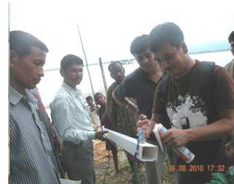
水位計（結線部をコーキング）
