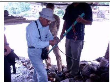
水位計センサーロッド点検、
