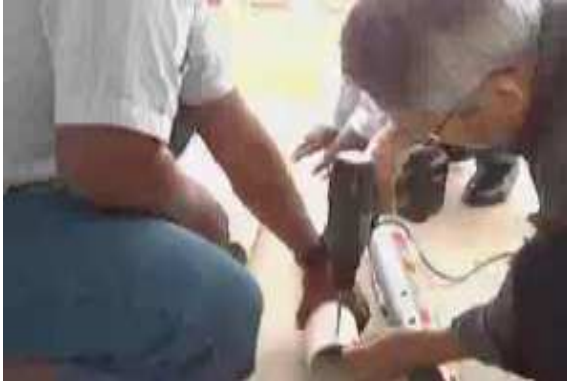
水位計ケーシング加工
