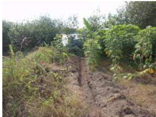
水位計接続ケーブル埋設溝
