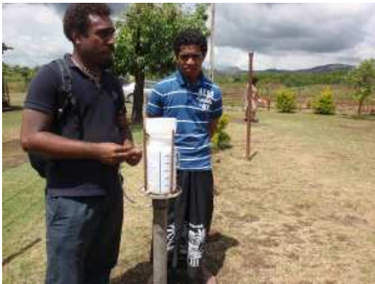
雨量計ケーブル結線
