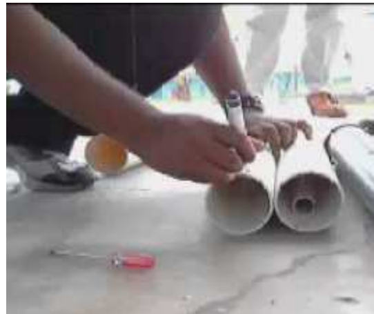
水位計ケーシング切断
