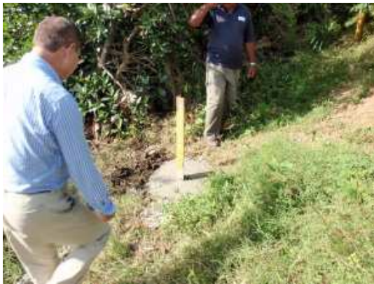
水位計添架用基礎とアングル
