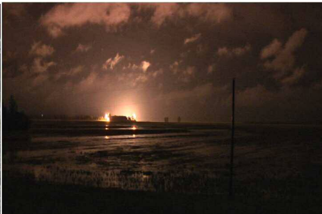
上流側堤防の爆破 状況(5/2 22:00)
