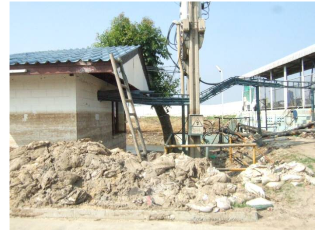
工業団地内部の被災・汚泥の堆積状況
