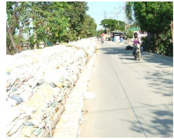
排水先河川左岸の土のう。浸水は生じなかった。39
