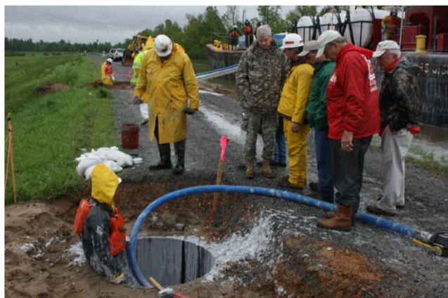
堤防爆破用薬剤の 充填状況(5/2)
