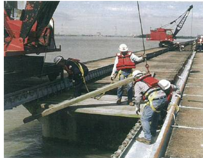
ゲート開放状況。通常時は36時間かかるが、緊急時は3時間で開放できる。
