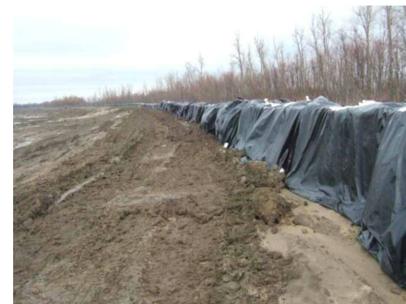
上流側堤防応急復旧状 況(2012年1月著者撮影)
