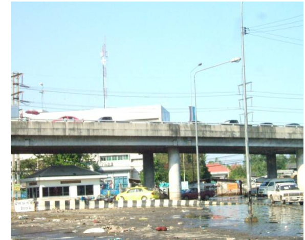
高架橋への車両一時避難の状況
