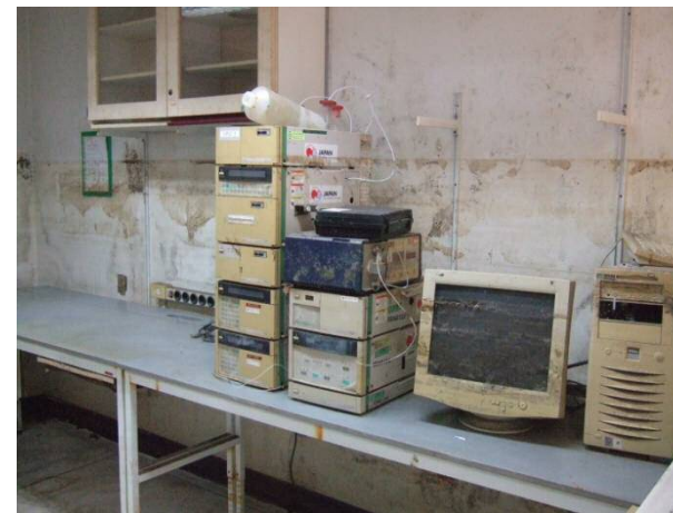
AIT校舎内の機材冠水・被災状況
