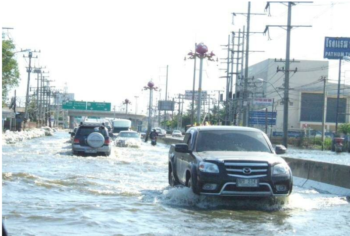
北部バンガディ工業団地周辺道路の冠水状況
