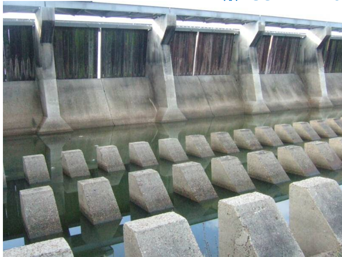
ゲート下流側より(2012年2月2日著者撮影)
