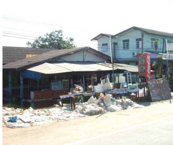
北部バンガディ工業団地周辺の家屋被災状況
