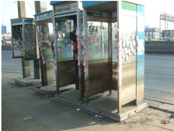
工業団地周辺で浸水痕跡の残る電話ボックス
