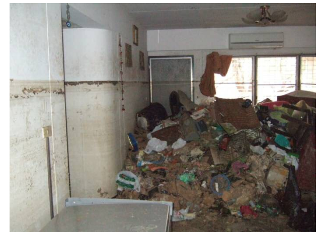
AIT敷地内住宅の冠水・被災状況
