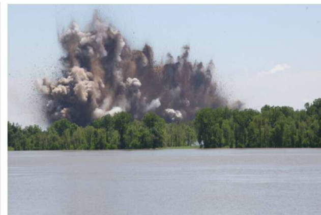
下流側堤防の爆破 状況(5/3 12:37)
