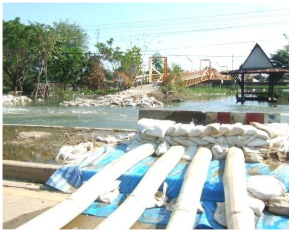
奥の河川への排水状況。手前が工業団地側
